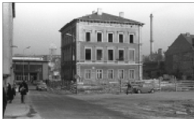
Przebudowa al. Konstytucji 3 Maja, lata 80.
