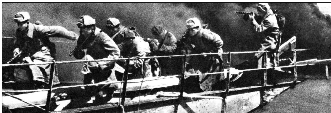
Przeprawa odrzańska, fot. 4, str. 217
