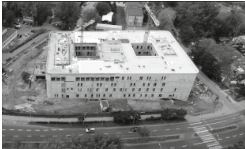
Il. 5. Budowa Centrum Zdrowia Matki i Dziecka w Zielonej Górze, wrzesień 2019 r.
