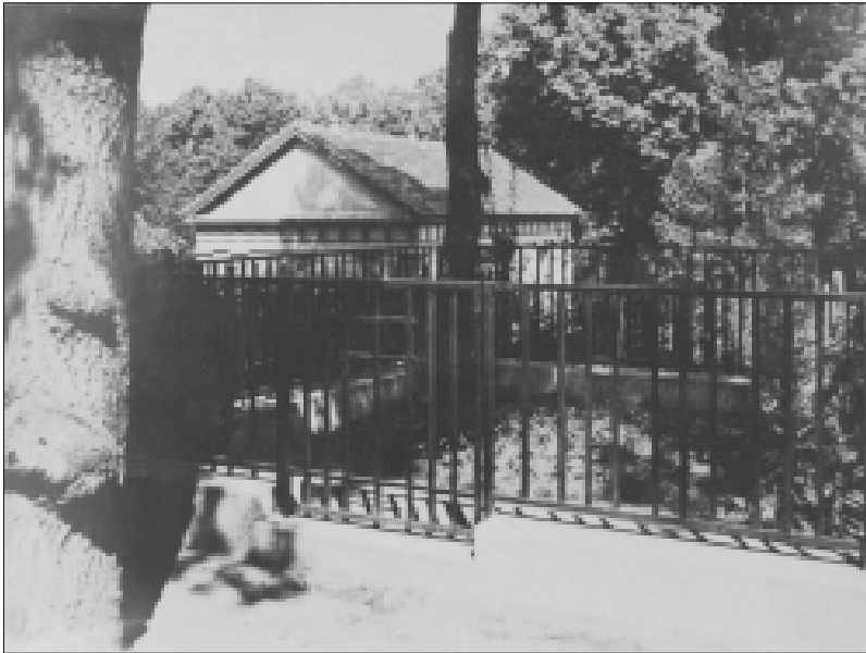
Il. 2. Dom pogrzebowy od strony ul. Wrocławskiej, stan przed 1945 r., ze zbiorów Grzegorza Biszczyńskiego
