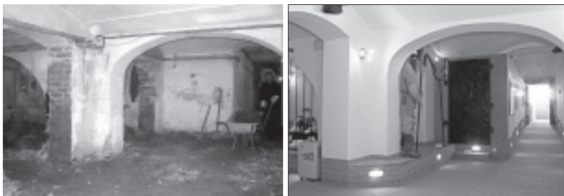
Piwnice w trakcie adaptacji i stan obecny
