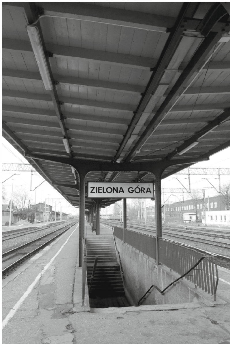
Zejsście do przejścia podziemnego na peronie drugim, fot. 2013 r.
