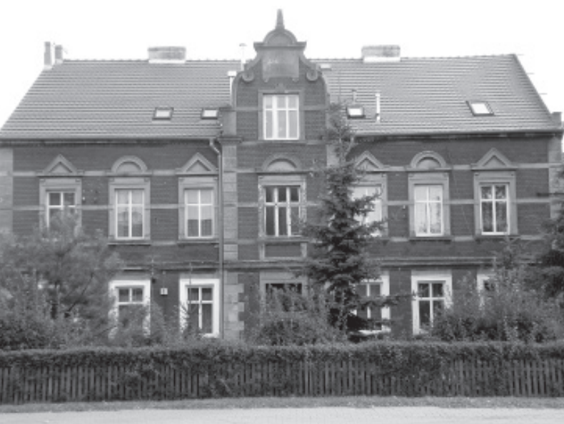
II. 4. Budynek mieszkalny rodziny Peschel wybudowany w 1901 roku. Obecnie jest to ul. Świerczewskiego (dawniej wieś Salkau) w Świebodziźnie. Stan z września 2012 roku, fot. Tomasz Kalicki
