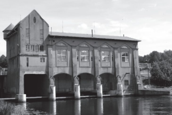
Il. 1. Elektrownia na Zalewie Bledzewskim
