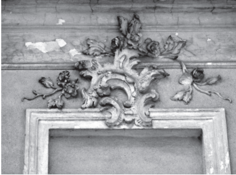
Il. 9, 10. Bojadła, pałac – sztukaterie elewacji (fragmenty), fot. Łukasz Klimczyk
