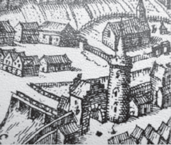
Il. 12. Widok Bramy Głogowskiej z drewnianą przeprawą wspartą na trzech podporach oraz drewnianą balustradą. Fragment ryciny Widok Świebodzina z atlasu G. Brauna i F. Hogenberga. Reprint z niekolorowanego oryginału znajdującego się w zbiorach Muzeum Regionalnego w Świebodzinie.
