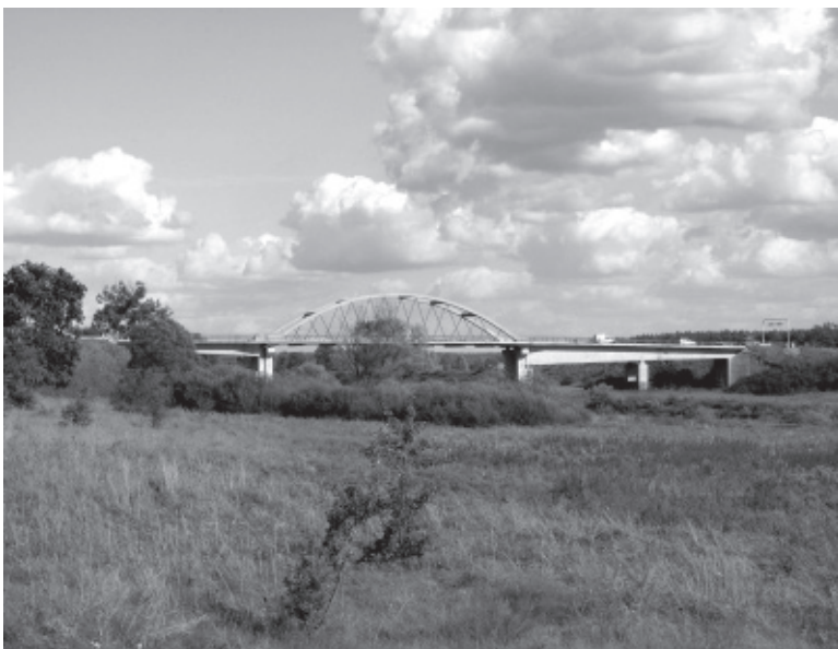
Widok na most drogowy przez Noteć w Starych Bielicach, fot. Grzegorz Urbanek 2007
