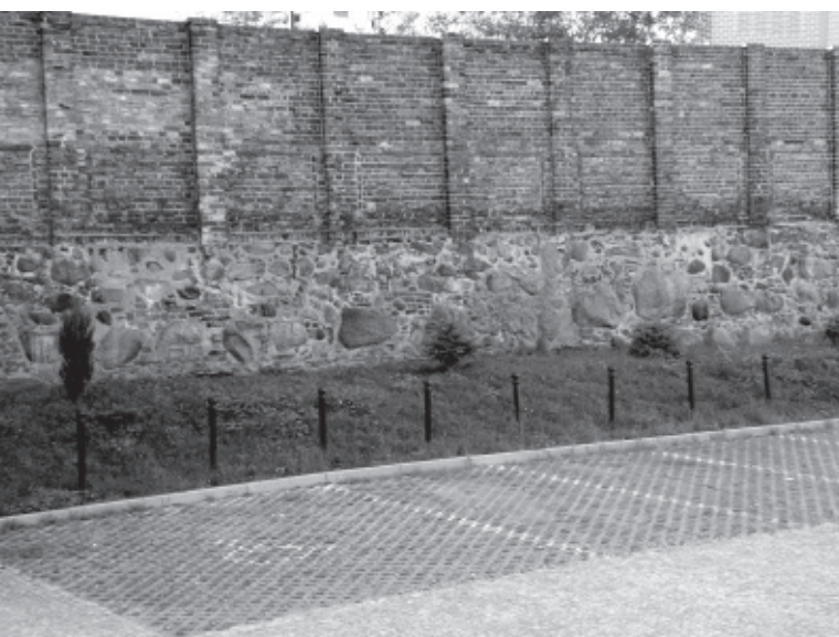
Il. 24. Obecny wygląd uzupełnionego w XIX wieku fragmentu muru obronnego przy ul. Wałowej, za budynkiem PKO. Stan z 3 lipca 2015, fot. Tomasz Kalicki
