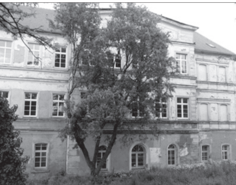
Il. 1. Dawny budynek SOSW przy ul. Okrężnej. Stan z 5 czerwca 2017 roku, fot. Monika Kalicka
