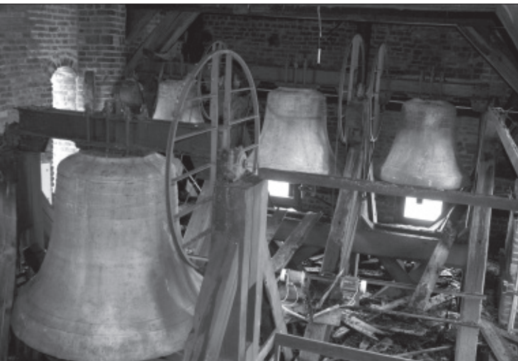
Il. 6. Widok na kondygnację wieży z dzwonami, fot. Dariusz Górny
