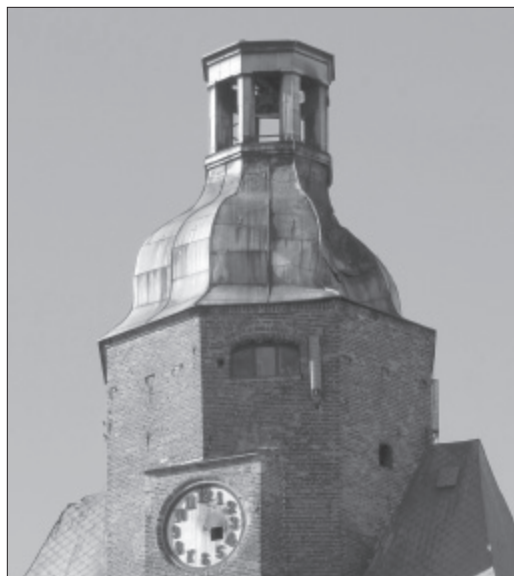
Il. 4. Tambur z hełmem i latarnią po pożarze, fot. Henryk Kustosz
