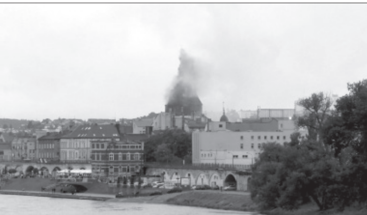
Il. 1. Płonąca wieża katedry, widok od strony Warty, fot. Henryk Kustos
