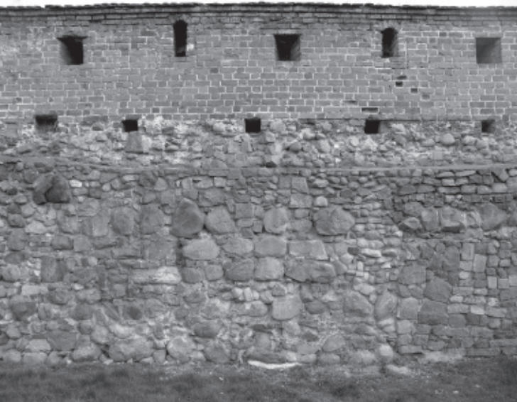
Il. 10. Zachowany fragment kamiennych murów obronnych z ceglana nadbudową, z przeprutymi w jej koronie otworami strzelniczymi.
