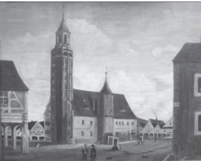
Il. 6. Ratusz w Sulechowie , 1. poł. XIX wieku, 1936 rok, F. Petras (kopia). Widoczna zabudowa ustawiona została szczytem do placu ratuszowego. Lokalizacja podcieni na
