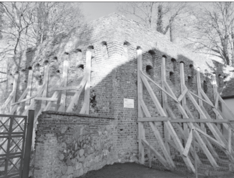
Il. 5. Fragment muru zamkowego z machikulami, narożnik południowo-zachodni. Widoczne elementy drewnianych wzmocnień,
