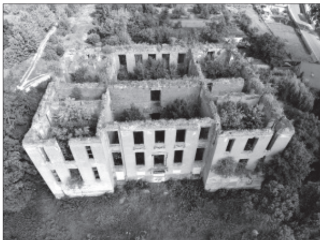
Il. 5. Widok na zamek przed przystąpieniem do prac zabezpieczających w 2019 roku, fot. Gmina Słońsk
