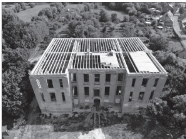
Il. 6. Zamek podczas prac zabezpieczających, 2020, fot. Gmina Słońsk
