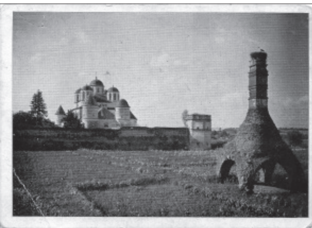
Il. 15. Międzyrzecz Ostrogski – cerkiew i mury obronne. Niegdyś wznosił się tu potężny zamek ks. Ostrogskich. Pozostał po nim tylko widoczny po lewej stronie malowniczy kuchenny komin, na którym uwily gniazdo bociany. Karta pocztowa z cyklu „Wołyń w zdjęciach fotogr. J. Bulhaka”, wydana nakładem Polskiego Towarzystwa Krajoznawczego Oddział w Łucku, a wydrukowana w Zakładach Drukarskich „Grafika” Wilno.
