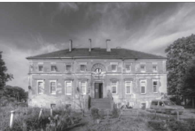
Il. 5. Elewacja frontowa pałacu. Widok współczesny. Fot. Kamilla Ernandes
