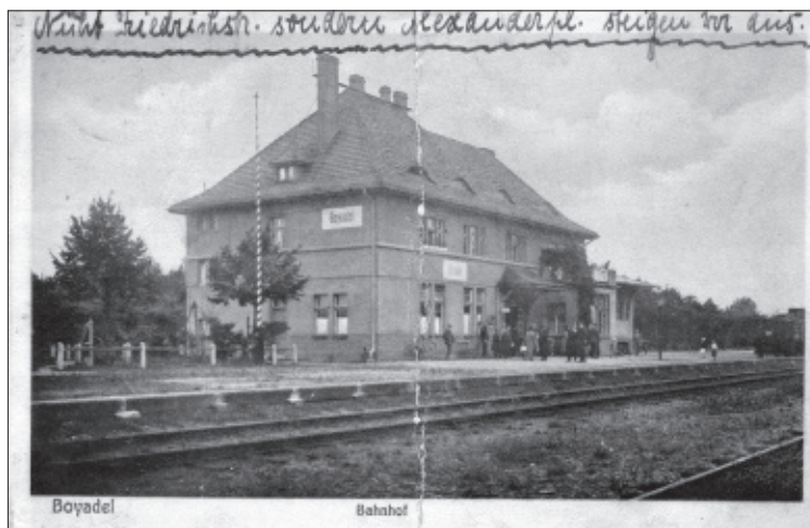
II. 2. Dworzec kolejowy w Bojadłach na karcie pocztowej wprowadzonej do obiegu pocztowego w 1934 roku, ze zbiorów Tadeusza Huńczaka
