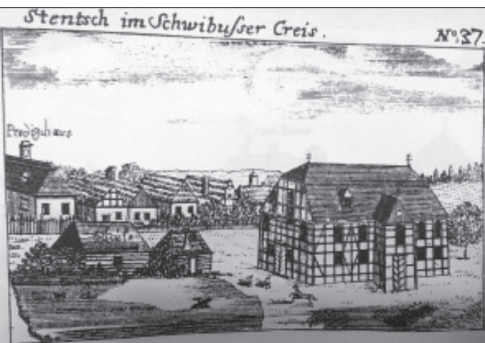
Il. 10. F.B. Werner, Zbór ewangelicki w Szczańcu. Schlesische Bethäuser... Ujęcie z szerszej perspektywy spowodowało wkomponowanie dodatkowych zabudowań widocznych na ilustracji, np. szkoły, plebanii, niewidocznych na il. 11. Przedstawiony budynek domu modlitwy nie różni się zasadniczo od późniejszego wykonania z piątego tomu Topografii Śląska , zob. il. 11.
