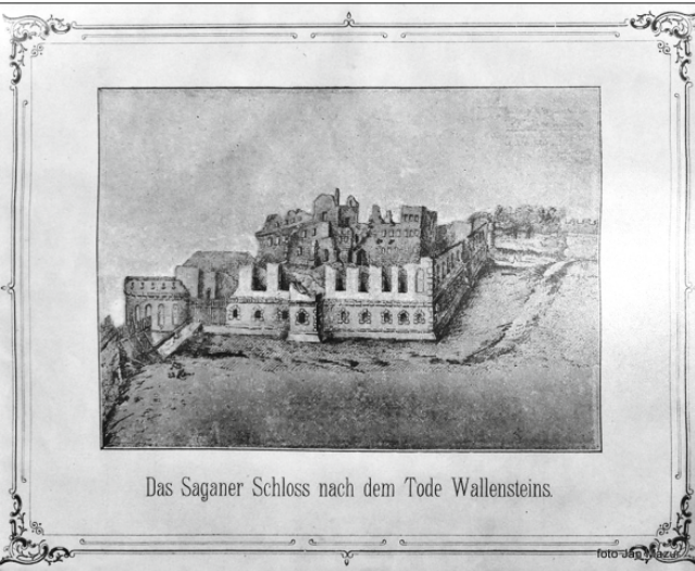
Il. 1. Rycina przedstawiająca pałac budowany przez Wallensteina. Wewnątrz realizowanej budowy widoczny średniowieczny zamek z przełomu XIII/XIV w. który jest sukcesywnie wyburzany
