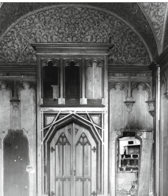
Il. 4. Ściana północnej kaplicy pałacowej z drzwiami wejściowymi, armarium po prawej oraz wnęką na piec po lewej stronie. Fotografia z 1957 r., Wojewódzki Urząd Ochrony Zabytków – Zielona Góra, M. Kutzner, Studium historyczno-architektoniczne...
