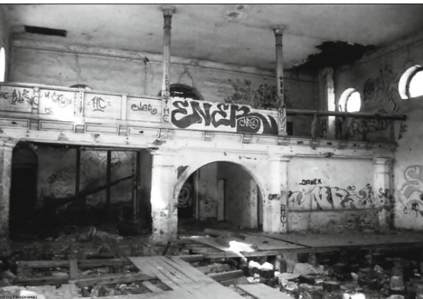
Il. 11. Wnętrze synagogi przed remontem, widok na empore, 2001, fot. Andrzej Paśniewski
